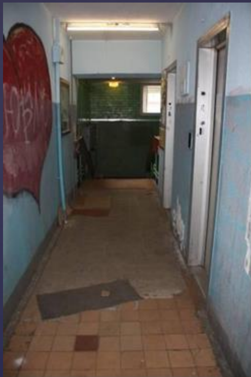
Пример обзорной фотосъёмки лифтовой площадки многоэтажного здания
